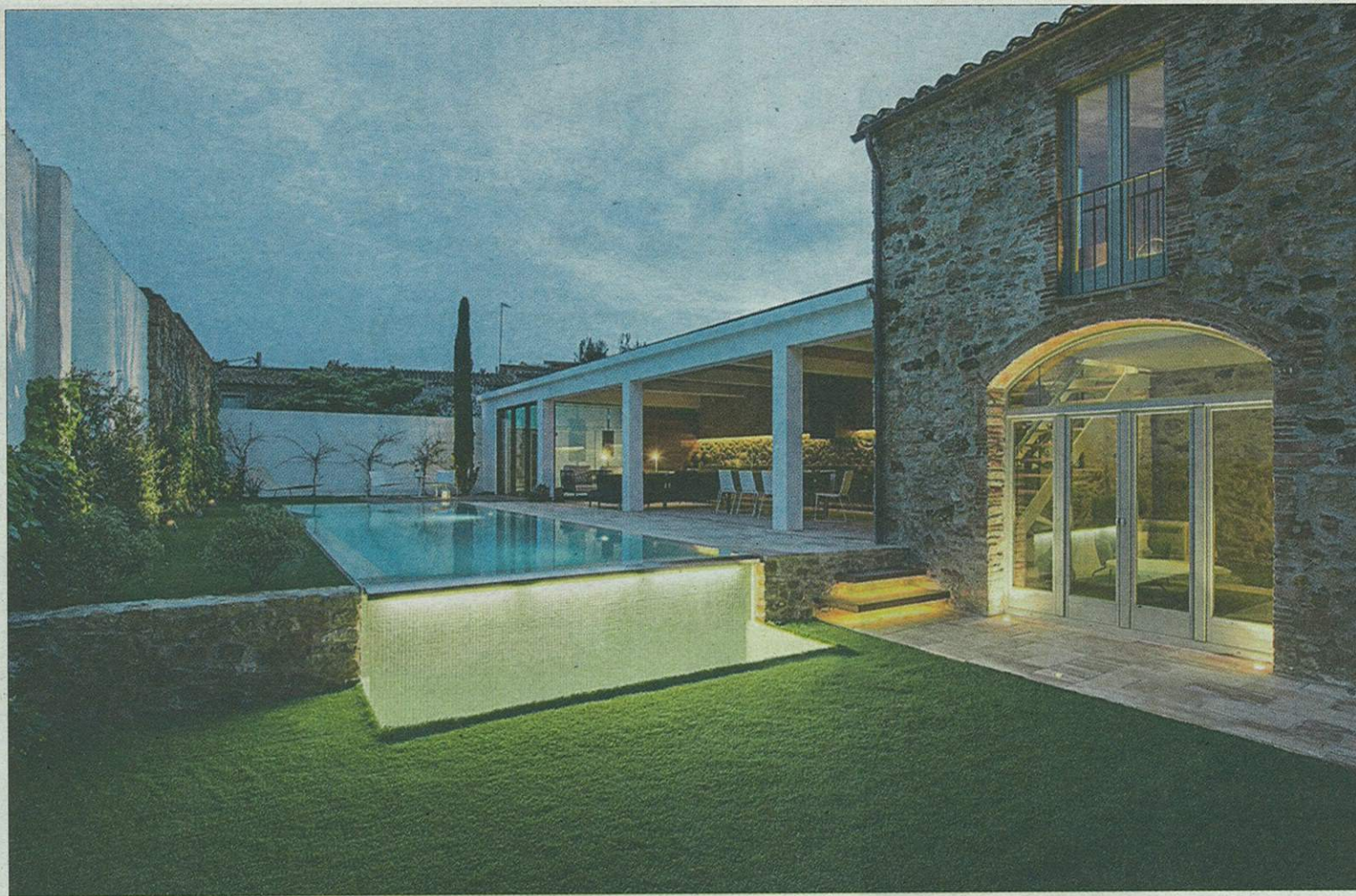
Propiedad de 1850 en Pals totalmente rehabilitada por la arquitecta Glòria Duran, en la que se ha potenciado la relación interior-exterior
