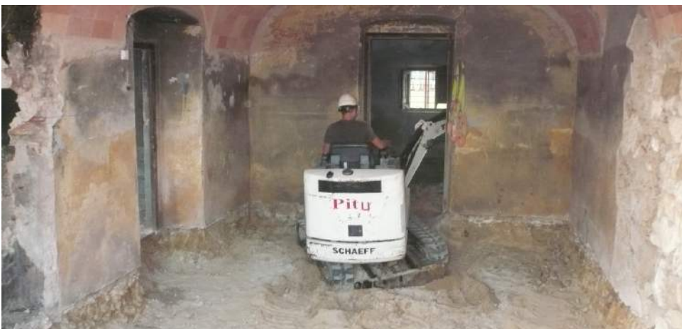
Rebaix interior Mas Moscat
