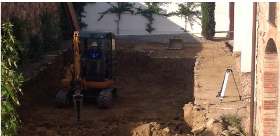
Excavació piscina casa Carrer Samària, 34 a Pals
