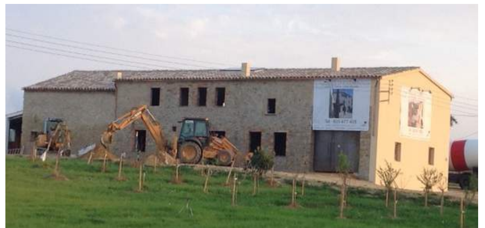
Instal·lació centre- depuració
