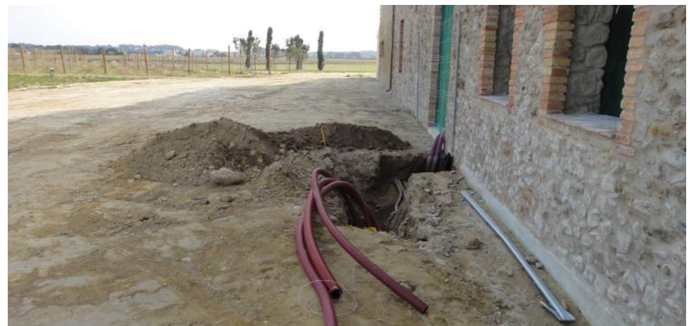
Excavació escomesa Mas Moscat
